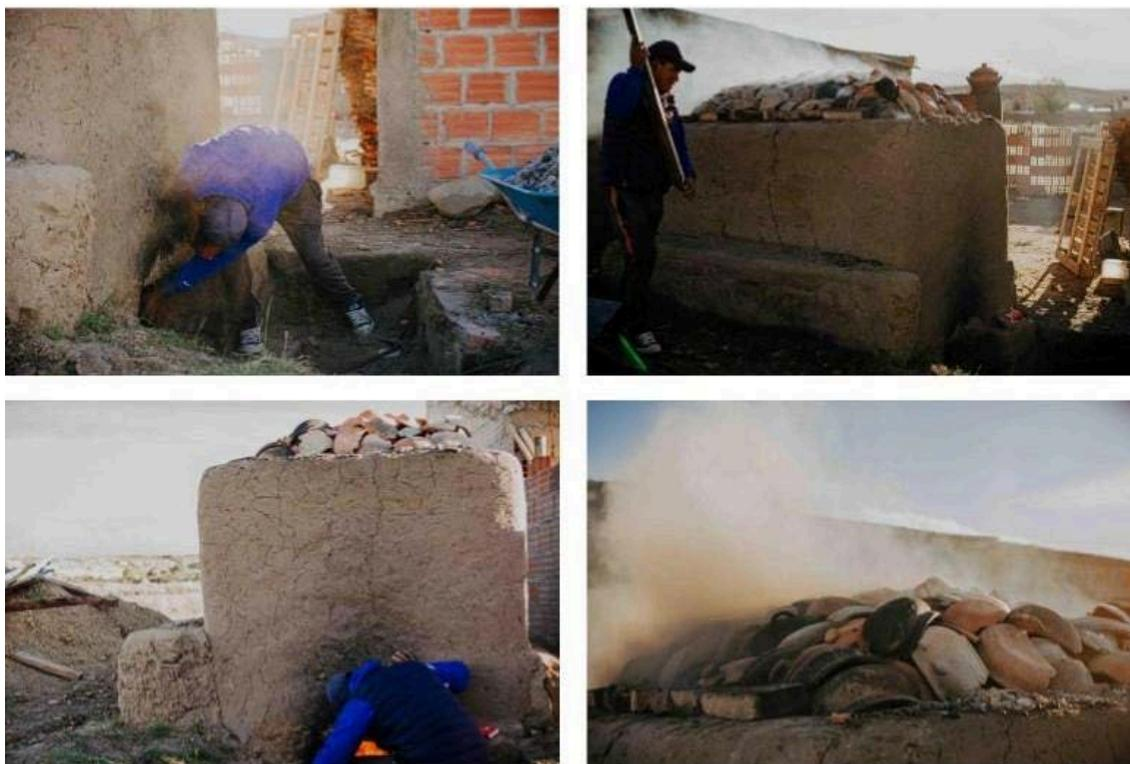
Figura 47: encendido del horno con la última luz del día
